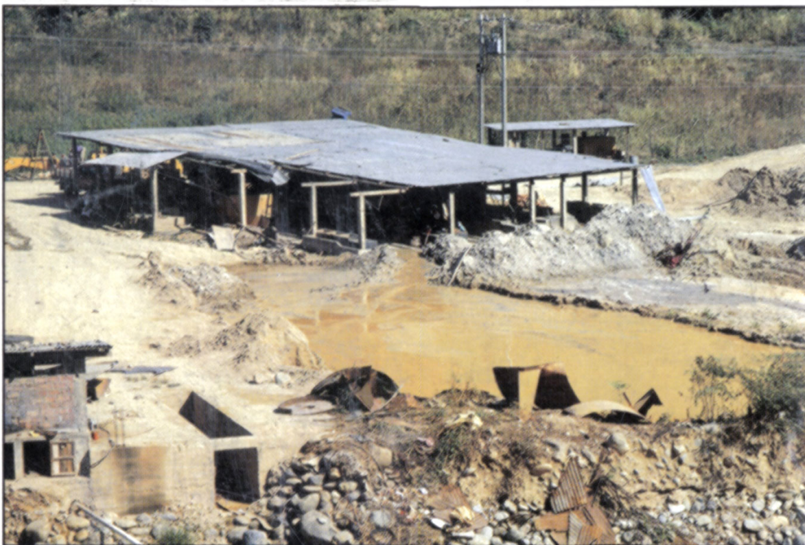
12. Minería primaria: planta de percolación (lixiviación con cianuro) (Portovelo, Ecuador)
