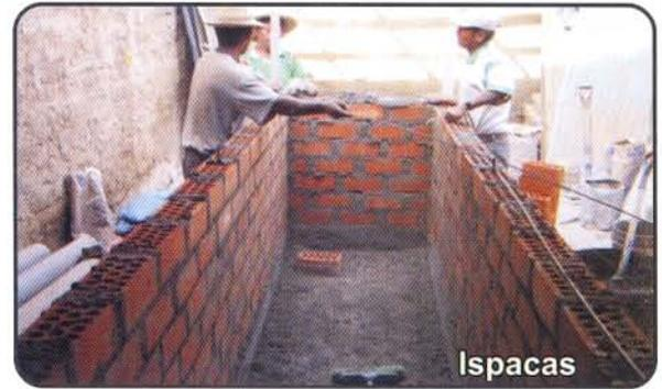
**Construcción del tanque – se nota los aros de fierro empotrados para reforzar las paredes del tanque**
